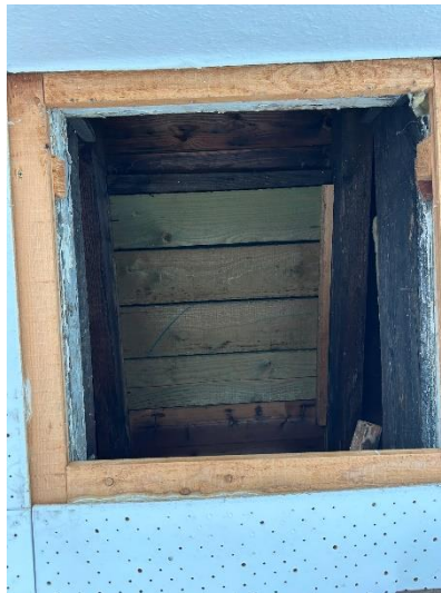
Abbildung 5 Decke über Obergeschoss, vorhandene Öffnung, Einblick in die Deckenkonstruktion
